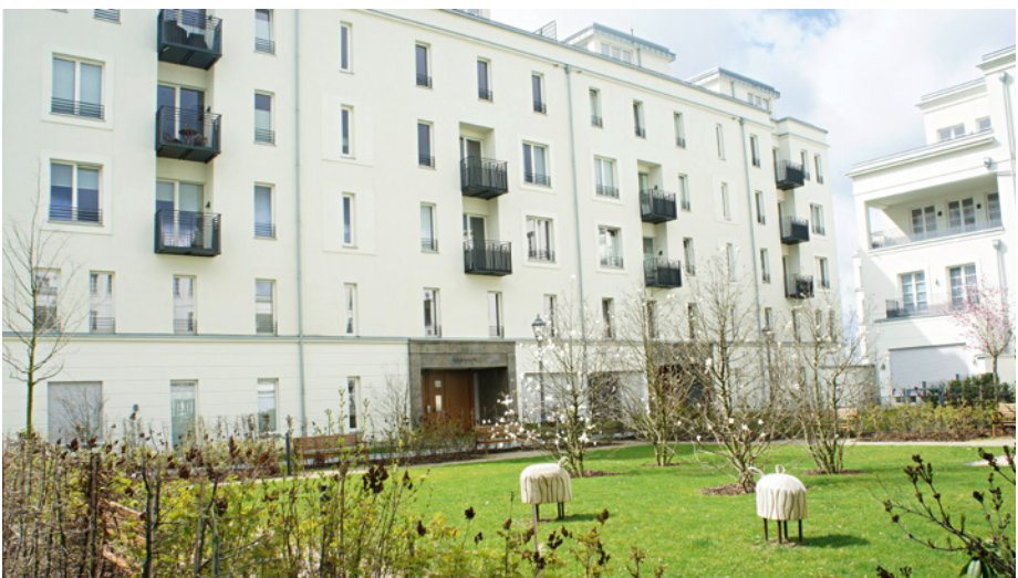
Heinrich Heine Gärten, Haus 21, Düsseldorf, nach Fertigstellung 2016
