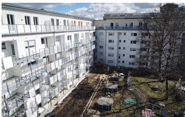
Wilhelm Sander-Wohnkarree, München Bogenhausen, bei der Sanierung
