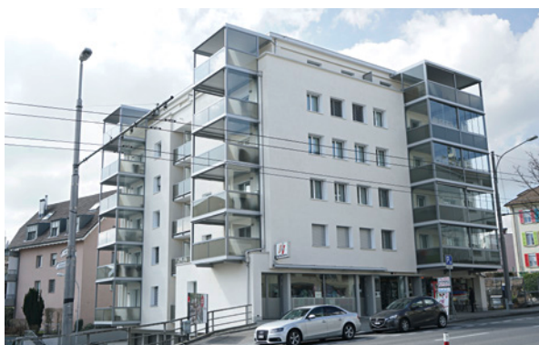
Wohnhaus Gerliswilstrasse, Luzern, Schweiz, nach der Sanierung
