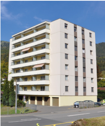
Wohnhaus Goldau, Schweiz, vor der Sanierung
