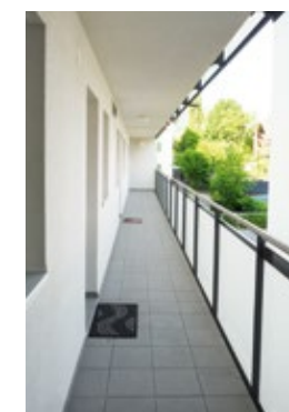
Sanierung eines Wohnhauses in Kriens, Schweiz, Luzerner Straße
