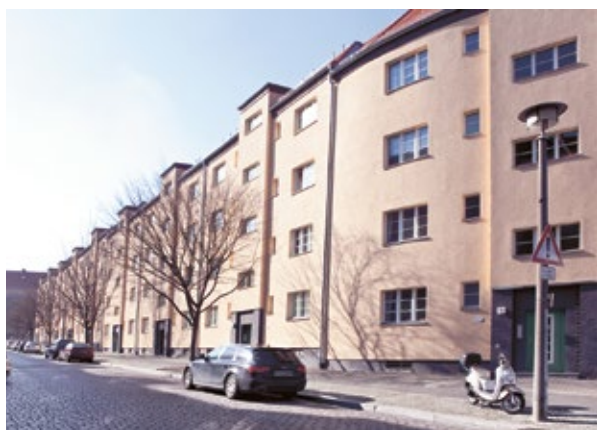
Blick von außen auf die Fassade
