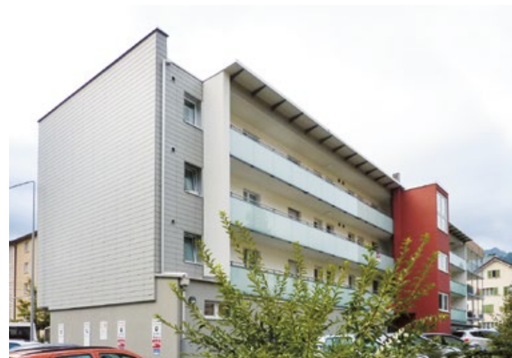
Unten: die neue Rückfassade des Hauses Luzerner Straße, Kriens
